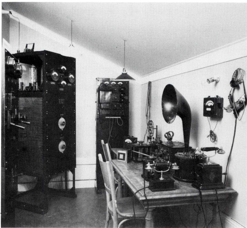
11. Rundradiostation, installerad på Telegrafverkets undervisningsanstalt 1923
