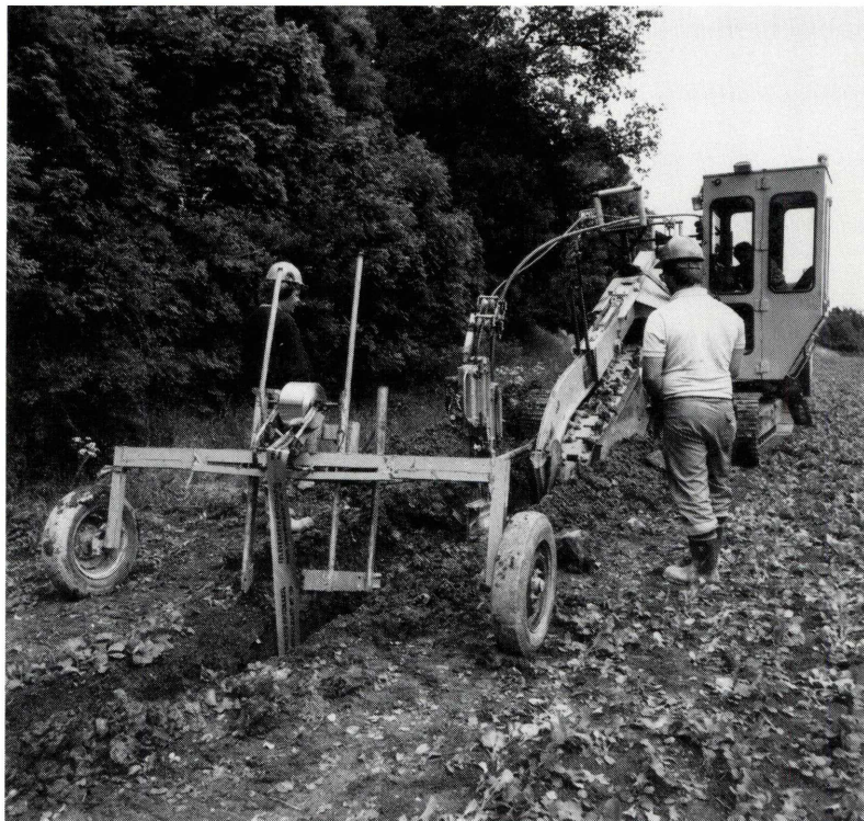
22. Modern maskinell nedläggning av optokabel.
