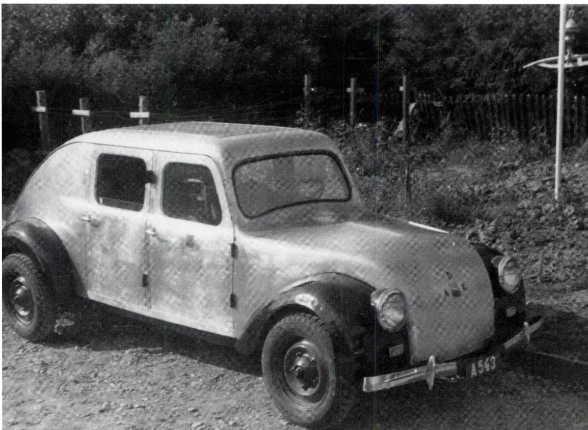
3. Världens första fordon med i kurvor lutningsbar kaross. 1953.
